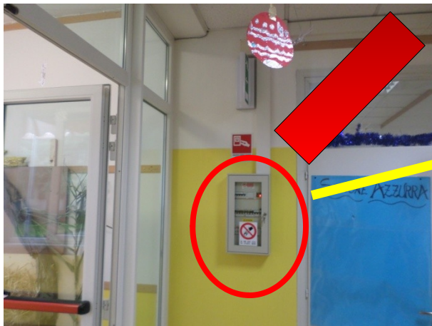
QUADRO GENERALE SCUOLA INFANZIA (zona collegamento secondaria-infanzia)
